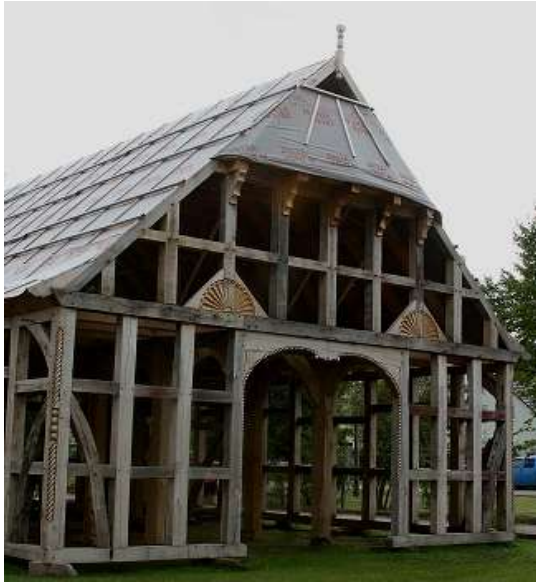
الشكل (16) تصميم نموذجي لبيت القاعة مكتملا والشكل الإنشائي للهيكل الخشبي - ألمانيا.
