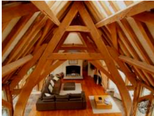
الشكل (15) يمين نموذج إنشائي للهيكل الخطافي مع رسم كروكي يوضح الفكرة الأساسية - إنكلترا.
